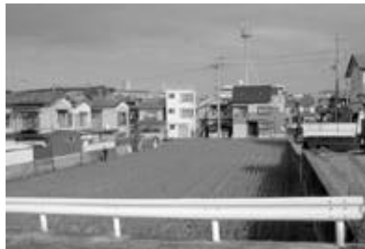
万千代川堤防より北を臨む。H12現在の様子。
