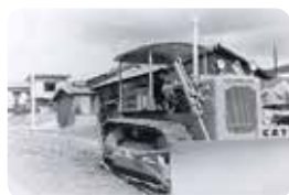
工事中の町内への進入道路
